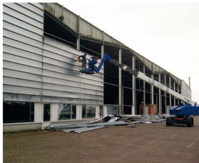
2. afbraak bestaande gevelbekleding
