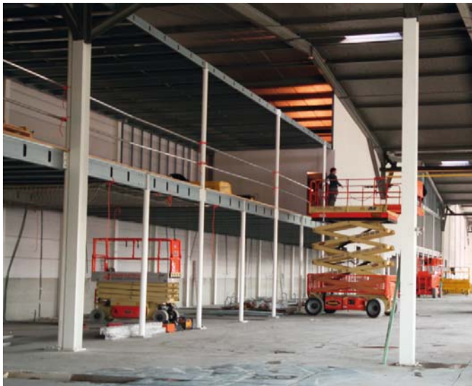
9. constructie draagstructuur nieuwe kantoren
