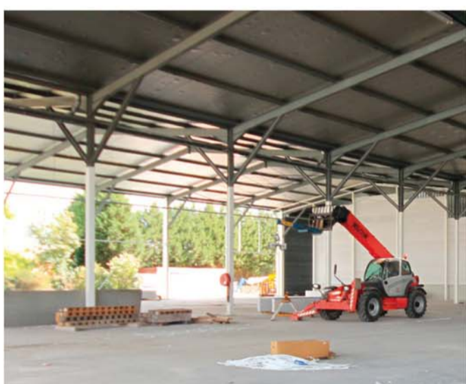
3. installatie brandmuur achterliggende oppervlakte
