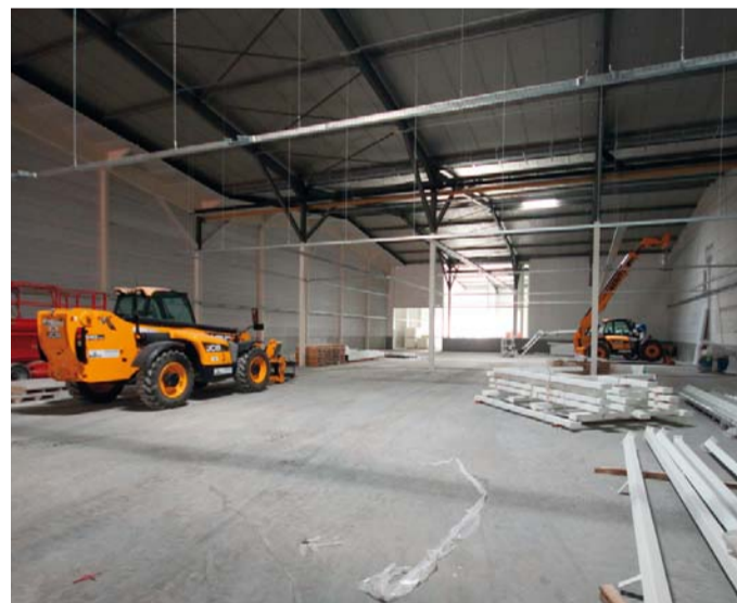
14. installatie kabelgoten voor elektriciteit in werkplaats
