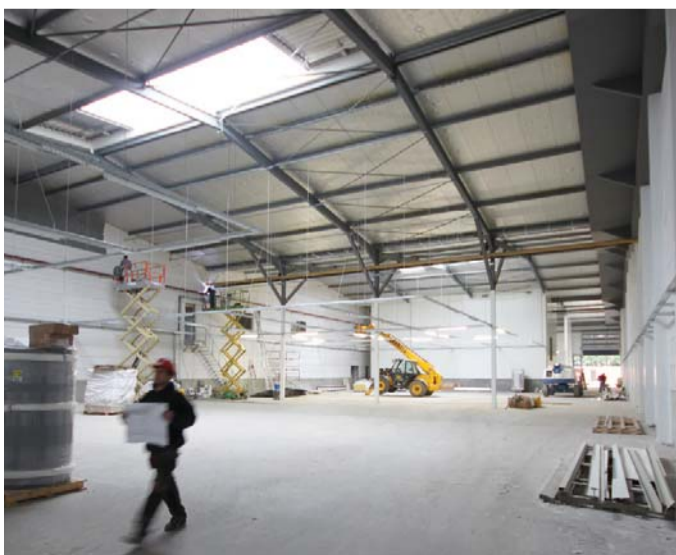
15. installeren verlichting en luchtextractiesysteem in werkplaats
