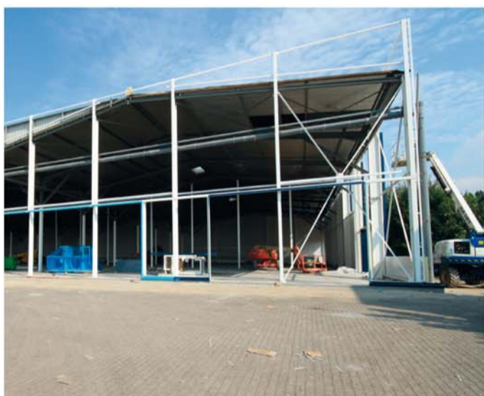
5. realisatie draagstructuur nieuwe gevelbekleding
