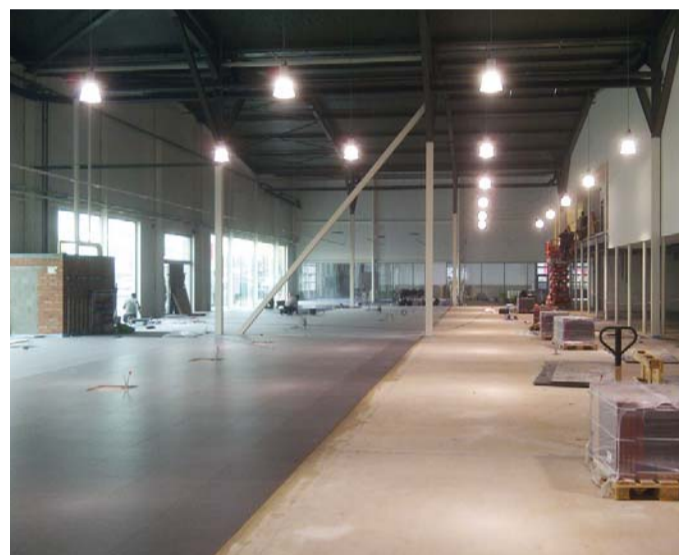
12. plaatsing vloertegels in showroom - afwerking kantoren
