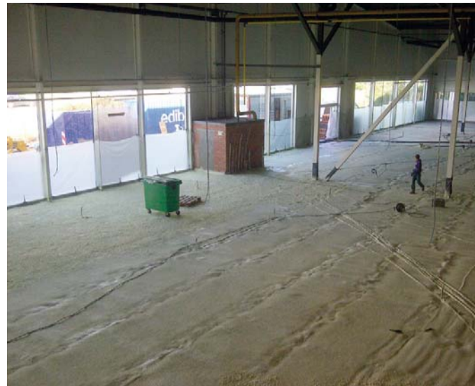
10. spuiten vloerisolatie in showroom
