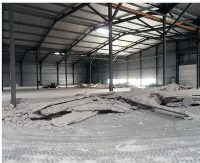
1. afbraak bestaande brandmuren en wanden
