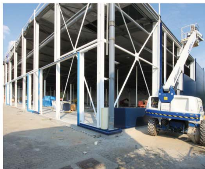
6. plaatsing sandwichpanelen nieuwe gevel
