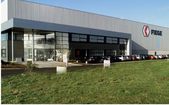
Puurs Logistic Center Puurs
