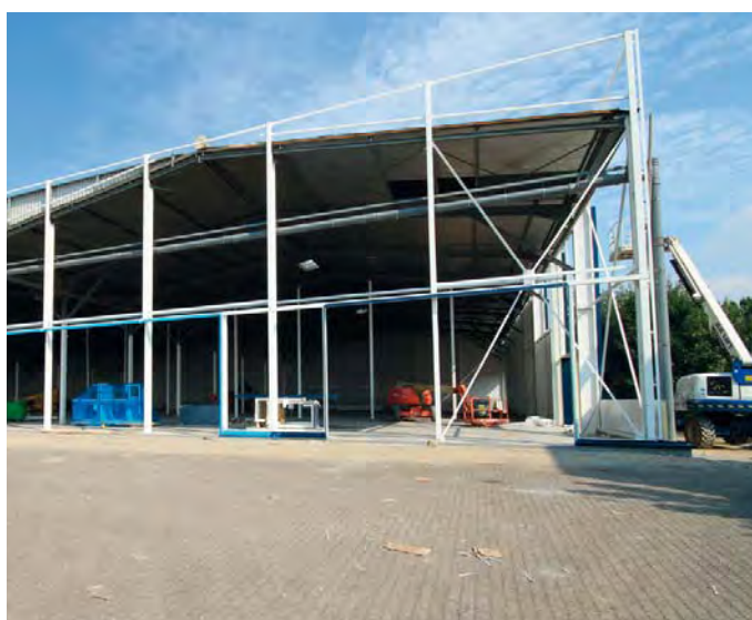
5. réalisation structure porteuse nouveau revêtement de façade
