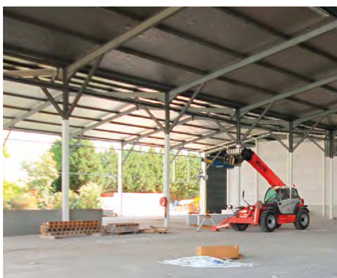
3. installation paroi pare-feu superficie arrière
