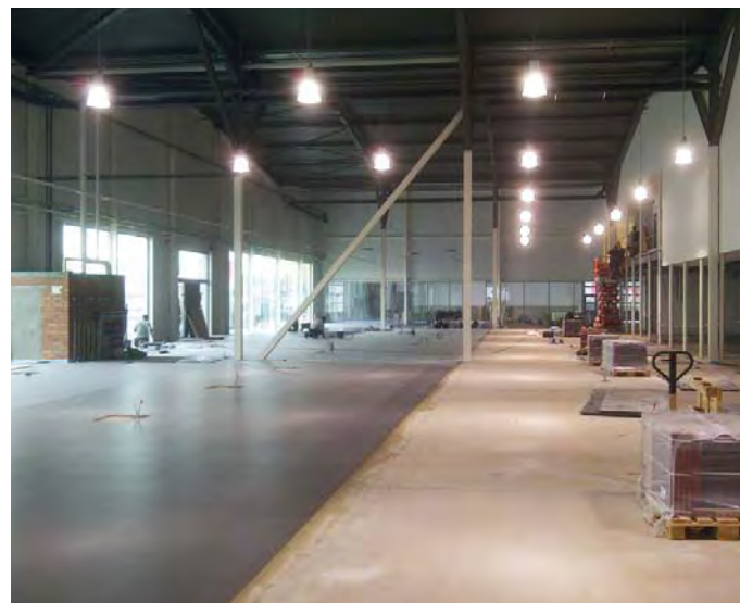
12. pose dalles de sol dans le showroom - finition bureaux
