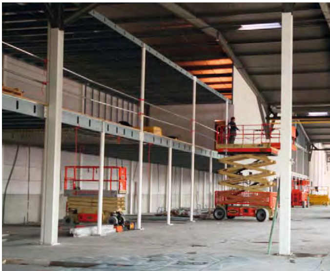
9. construction structure porteuse nouveaux bureaux
