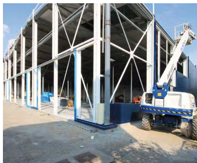
6. installation panneaux sandwich nouvelle façade
