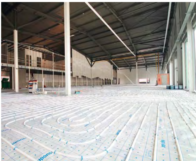
11. installation chauffage au sol dans le showroom
