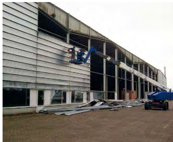
2. démolition du revêtement de façade existant
