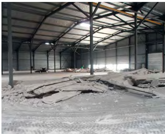
1. démolition parois pare-feu et cloisons existantes
