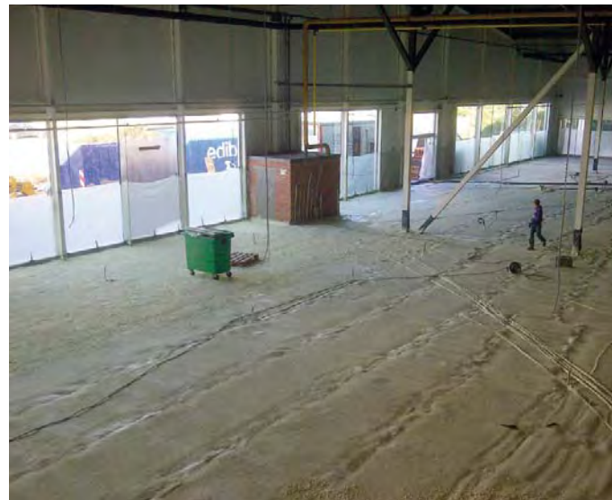
10. pulvérisation isolation du sol dans le showroom
