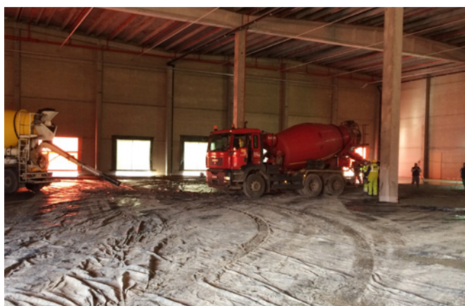
▲ Aménagement du sol
