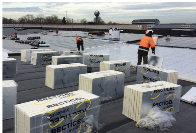
▲ Liège - Placement isolation de toiture nouvelle construction magasin cross-dock
