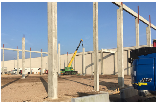
▲ Structure à colonnes
