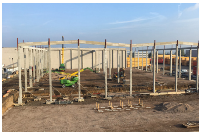
▲ Structure à colonnes
