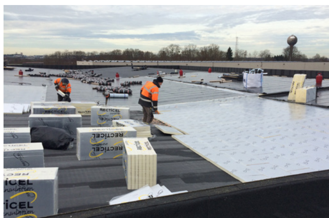
▲ Travaux de toiture
