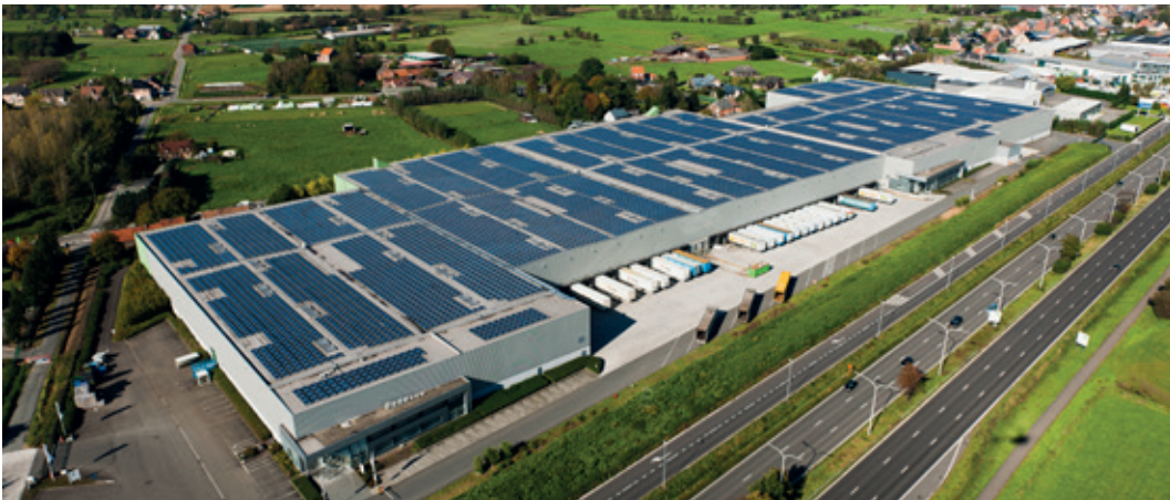
▲ En haut: bureaux - Mechelen Campus. En bas: immobilier logistique - Puurs
