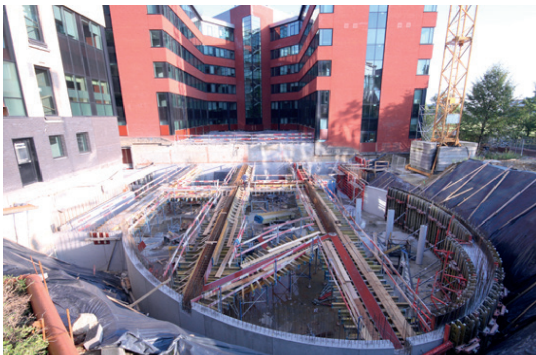
▲ Greenhouse BXL - L'auditorium se concrétise
